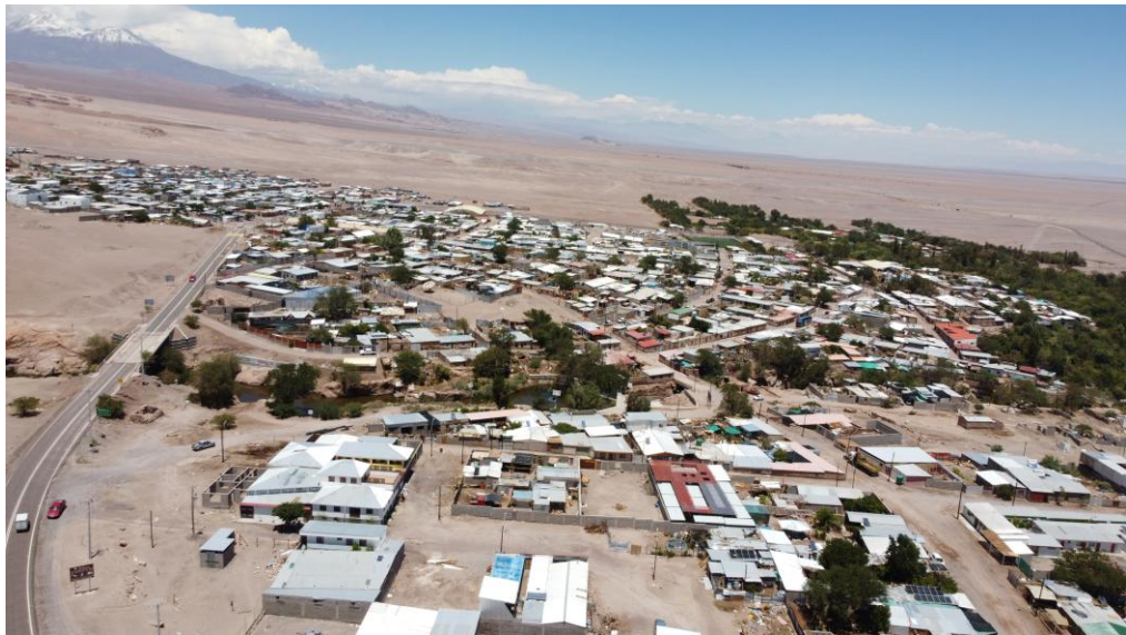
Viviendas e infraestructuras susceptibles a incendios estructurales. Fuente: Elaboración propia (2026)
